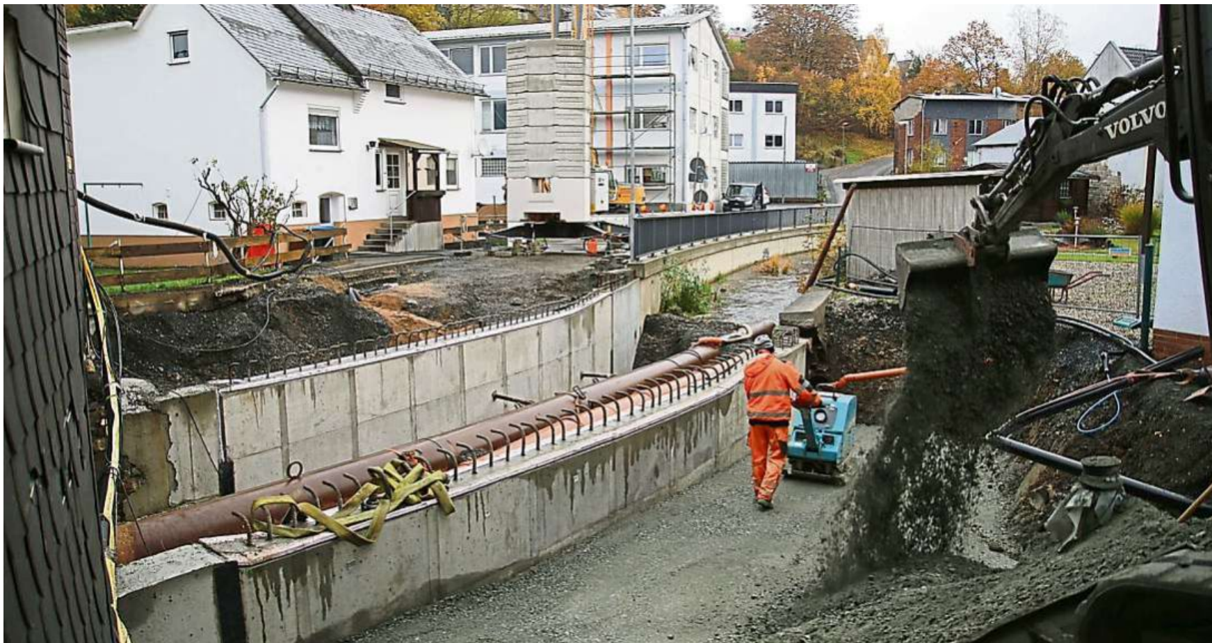
Großbaustelle: Die Kosten für den Neubau der Dietzhölzbrücke in der Hallstraße in Ewersbach fallen höher aus, als geplant war. Im Haushalt für 2020 stehen noch einmal 80 000 Euro für das Projekt, das im Frühling kommenden Jahres fertig werden soll. Foto: Frank Rademacher
