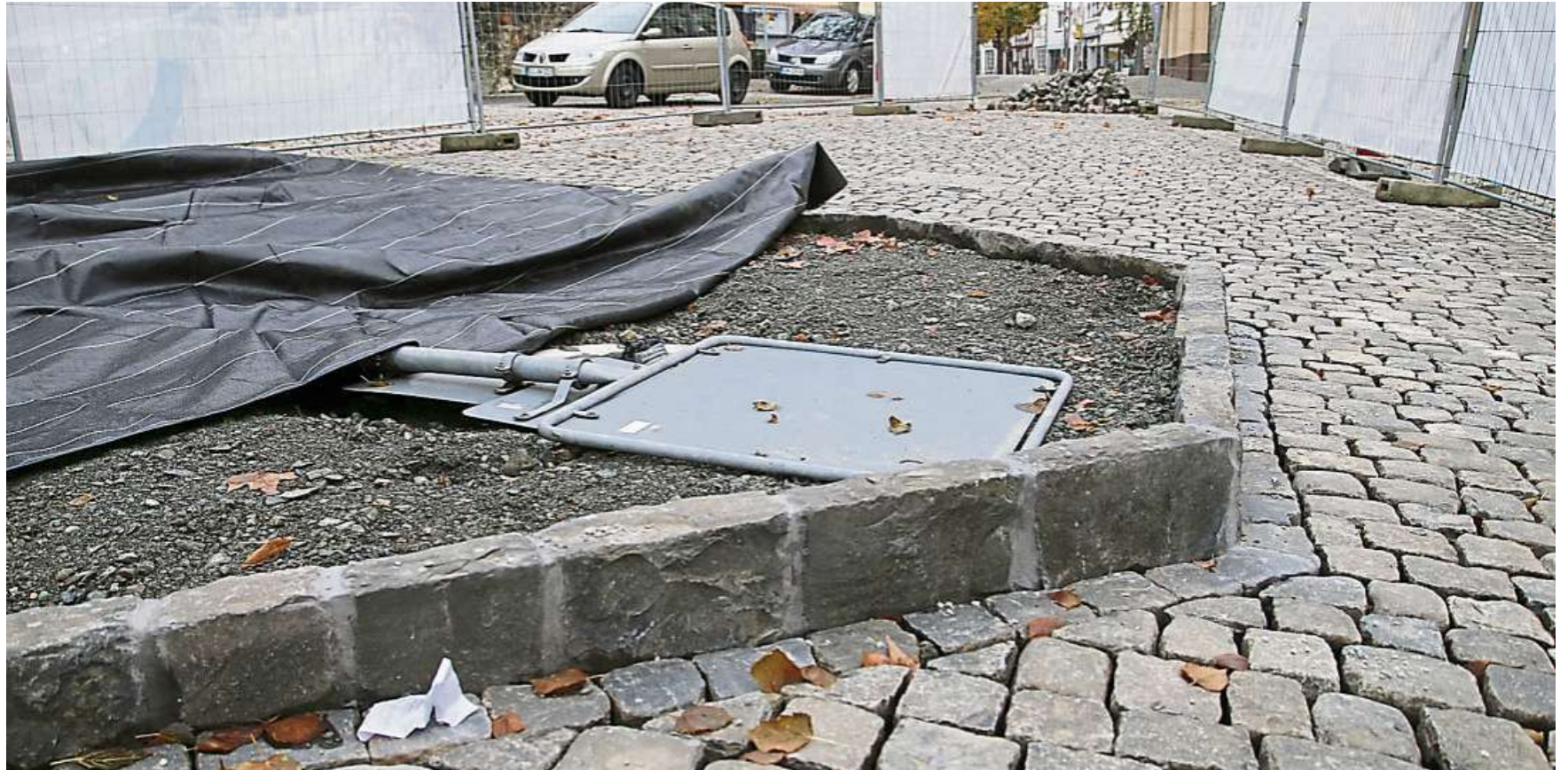
Fakten geschaffen: Bauleiter Jens Backhaus hat schon mal eine Einfassung für den Brunnen auf dem Wilhelmsplatz anlegen lassen.
